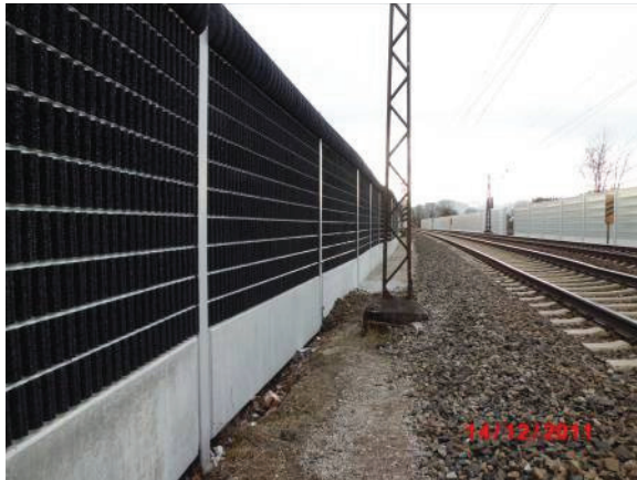
Bild 45: Ansicht Schallschutzwand mit Aufsatz Gleisseite
