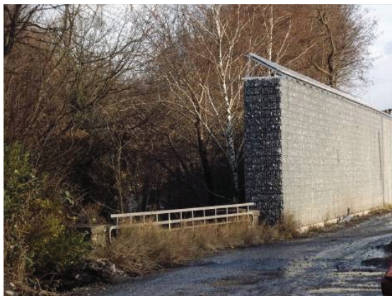
Bild 41: Gabionen-SSW mit FV in Duisburg
