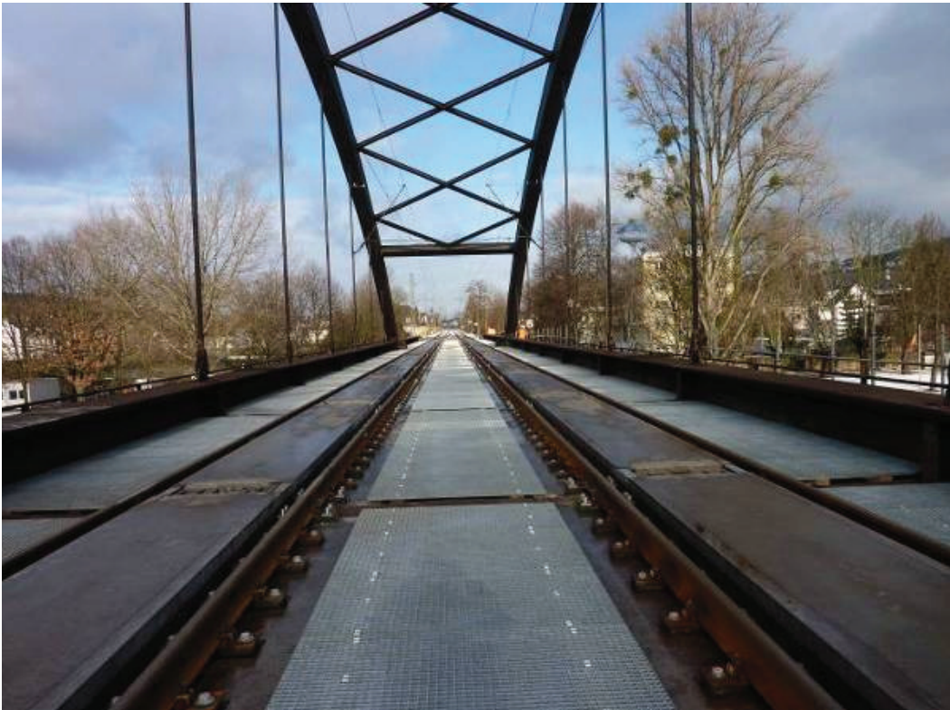
Bild 13: Direkt befahrene Stahlbrücke, Bsp. EÜ Lahnstein
