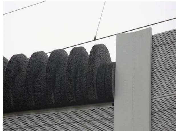
Bild 44: Beugekante als Aufsatzelement auf SSW
