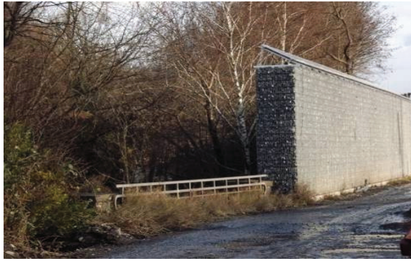
Bild 36: Gabionenwand Duisburg Ruhrort-Hafen
