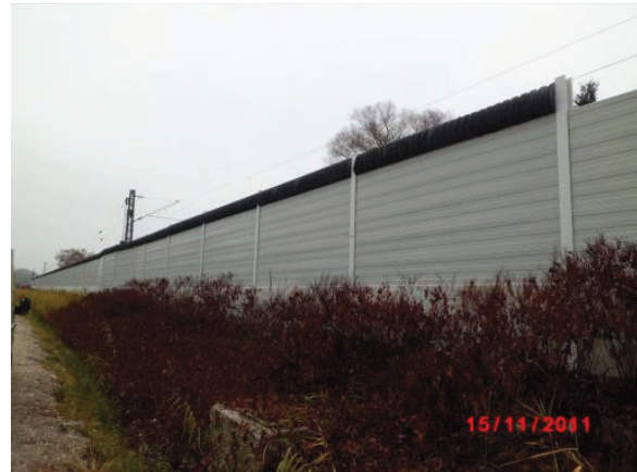
Bild 46: Ansicht Schallschutzwand mit Aufsatz Feldseite
