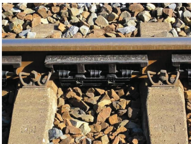
Bild 4: Beispielfoto für die Technologie Schienenstegdämpfer
